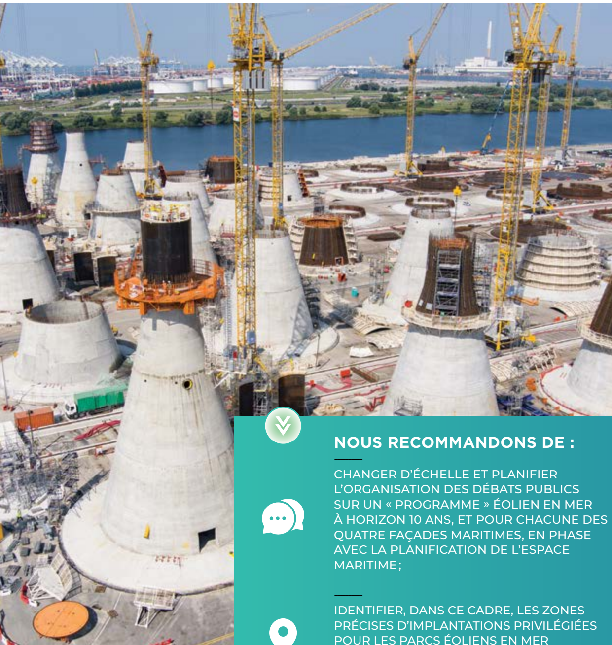
CHANTIER DE CONSTRUCTION DES FONDATIONS GRAVITAIRES DU PARC ÉOLIEN EN MER DE FÉCAMP
