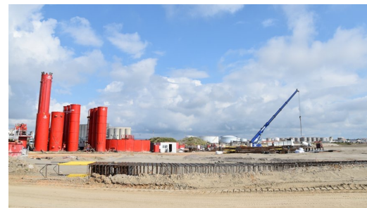
Aménagement du port de Port-la-Nouvelle
